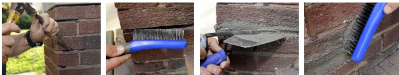
Slika 25. Djelomična zamjena morta u sljubnicama
