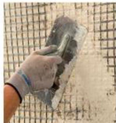
Ugradnja FRCM sustava
