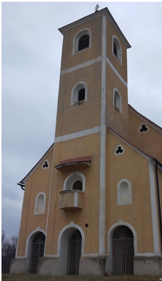
Slika 5. Pogled na crkvu – JZ pročelje
